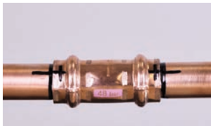
10. Verpresste Verbindung markieren
