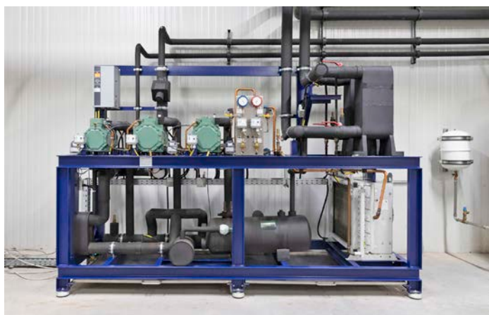
CO 2 -Tiefkälteanlage für einen Tiefkühlagerraum
