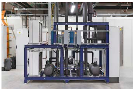
CO 2 -Tiefkälteanlage zur Scherbeneisbereitung
