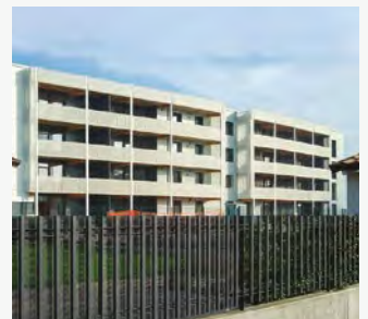
Crosslight House. Wohngebäude. Mulazzano, Italien. PACi und nanoe™ X
